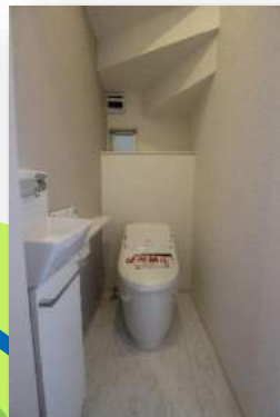
1Fトイレはタンクレス
